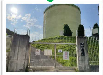
北部長尾配水池
