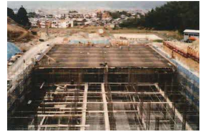
津田低区配水場（建設中）
