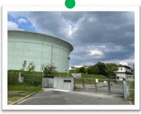
田口山配水池
