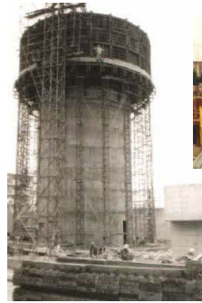
中宮浄水場 高架水槽（建設中）
