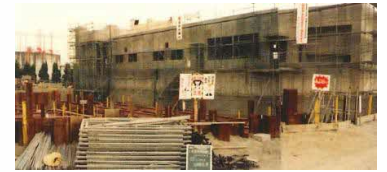
磯島取水場（建設中）
