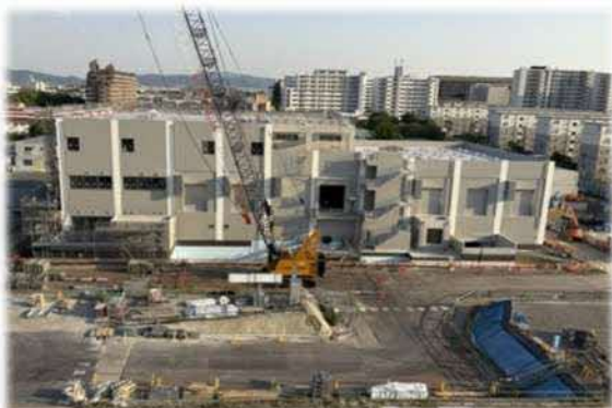
施工状況（令和8年5月15日撮影）
