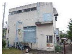
安居川ポンプ場
