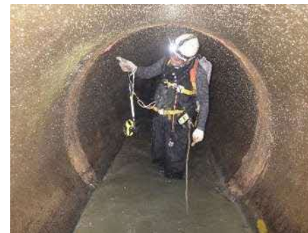
【管路の点検・調査】
