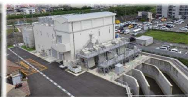
完成した新安居川ポンプ場
