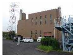
藤本川ポンプ場
