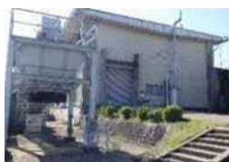
北部ポンプ場
