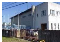
溝谷川ポンプ場
