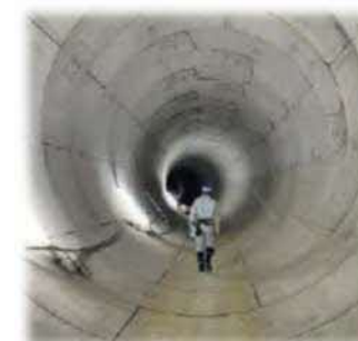
完成した貯留管の内部
