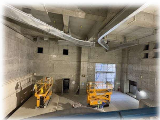
—膜ろ過棟内部—
