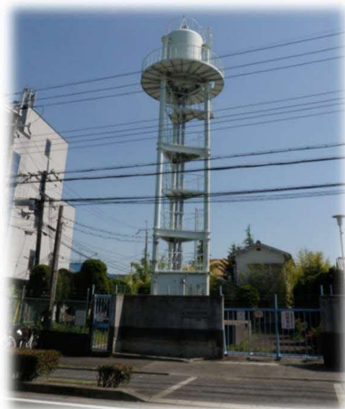
—東香里高架水槽（当時）— 高さは約23mありました
