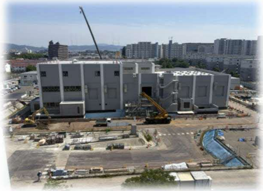
—工事全景（北側から）—
