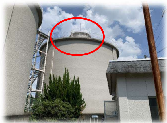
—楠葉配水場の高架水槽—
