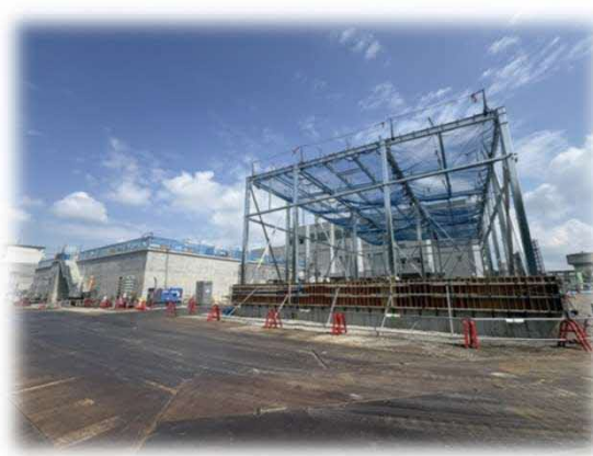
—薬品貯蔵棟— (全体完成図 写真②)
