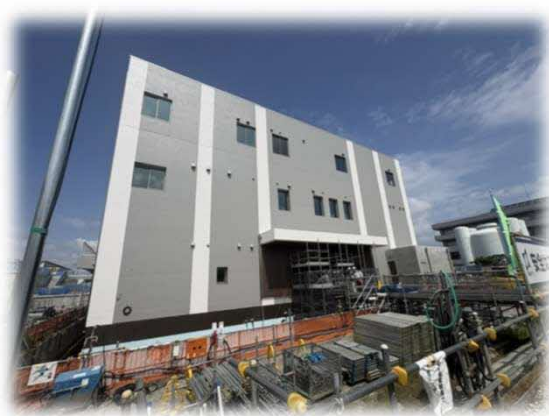
—膜ろ過棟— (全体完成図 写真①)
