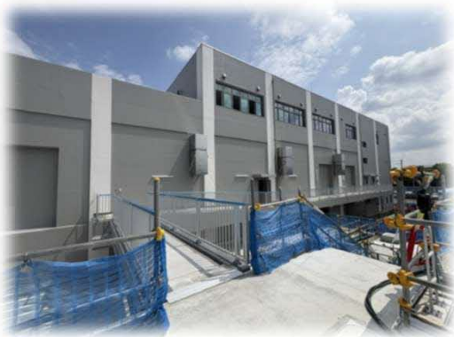
一渡り廊下— 前処理施設と膜ろ過棟をつなぐ廊下です (全体完成図 写真③)
