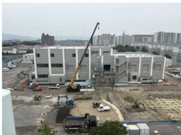
中宮浄水場更新用地 令和8年7月1日撮影
