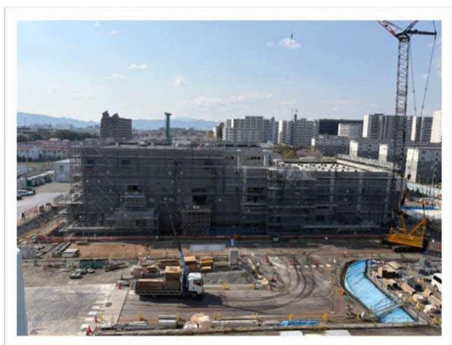
中宮浄水場更新用地 令和8年4月2日撮影
