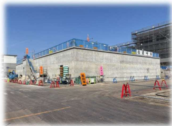
—前処理施設— (全体完成図 写真①)
