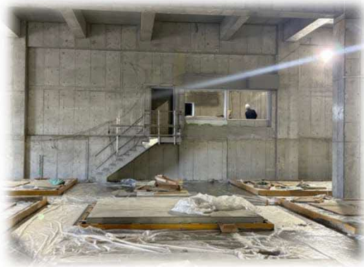
—膜ろ過棟 1F 配管室—
