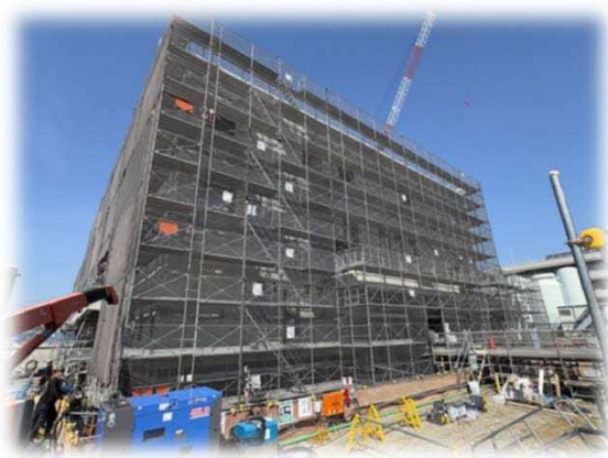
—膜ろ過棟— (全体完成図 写真②)
