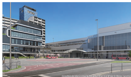
拡張整備後の市駅北側ロータリー
