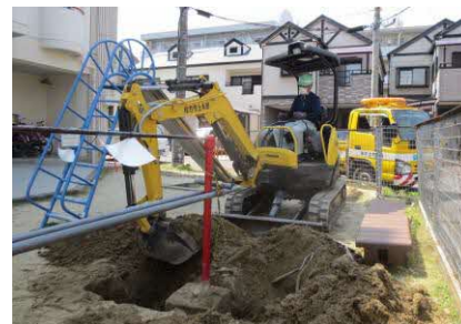
《鉄棒遊具不良に伴う補修作業》
