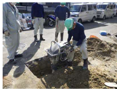
《道路陥没の復旧作業》
