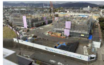
工事状況（令和7年2月時点）
