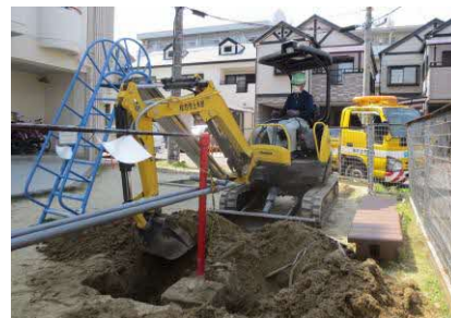
《鉄棒遊具不良に伴う補修作業》
