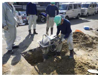
《道路陥没の復旧作業》
