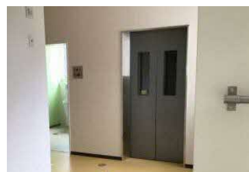
学校エレベーター
