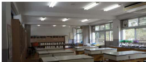
照明器具のLED化
