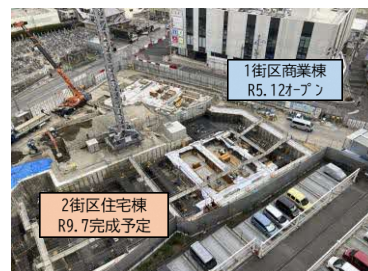
マンションの工事状況（令和7年3月時点）
