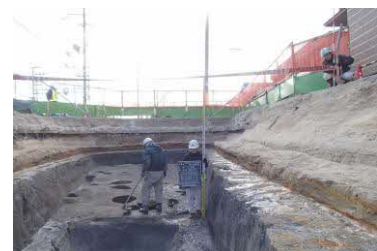
文化財調査の掘削状況
