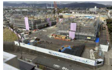
工事状況（令和7年2月時点）
