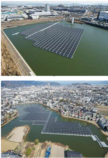
フロート式太陽光発電設備 上：招提新大池 下：招提今池
