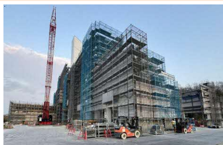
可燃ごみ広域処理施設
