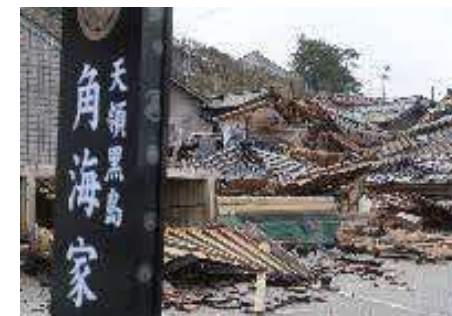
能登半島地震により倒壊した家屋
