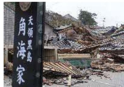
能登半島地震により倒壊した家屋
