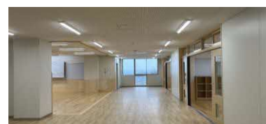
工事状況（令和8年3月時点）
