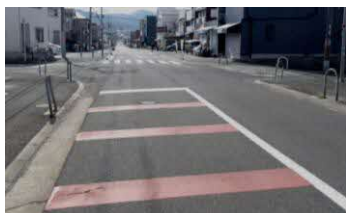
《横断歩道があることを強調する路面標示》
