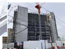
マンション建築工事状況
