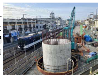
工事状況(国道1号南側、P1橋脚)
