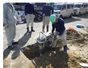
《道路補修作業》
