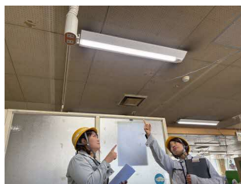
照明器具のLED化改修工事
