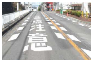
《路面標示の引き直し》
