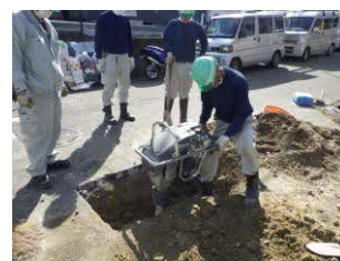
《道路補修作業》
