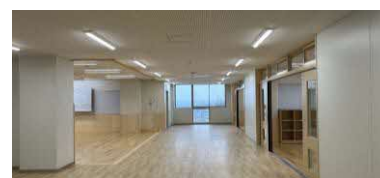
工事状況（令和8年3月時点）
