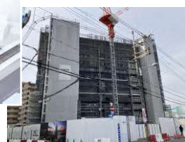
マンション建築工事状況
