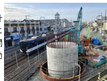
工事状況(国道1号南側、P1橋脚)
