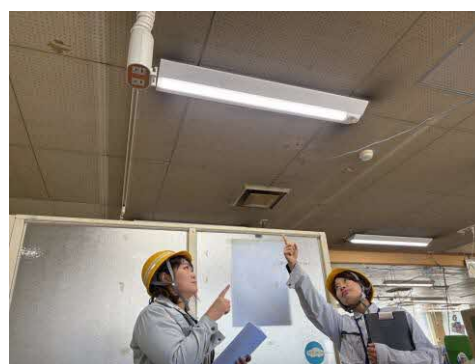
照明器具のLED化改修工事
