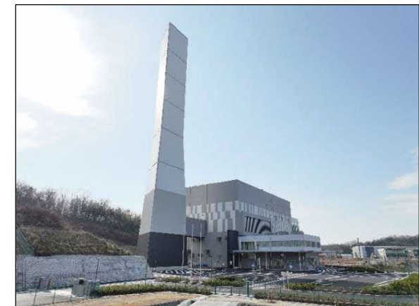
可燃ごみ広域処理施設
