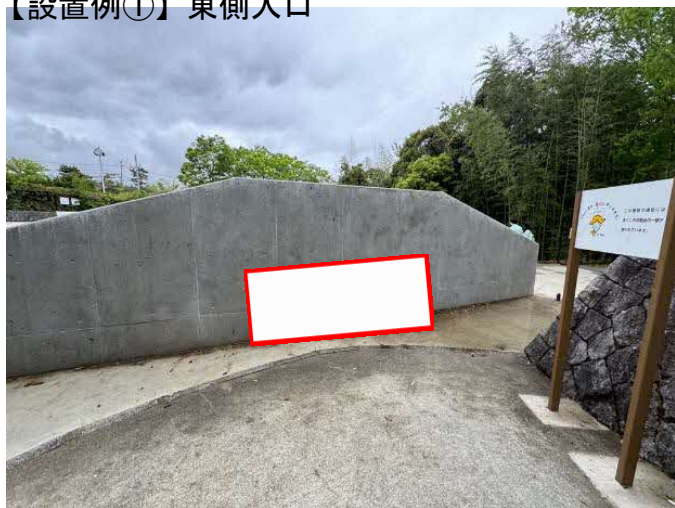
【設置例①】 東側入口
