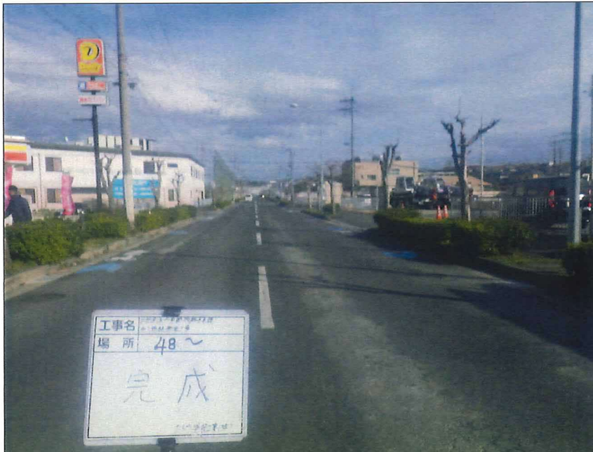
写真区分: 着工前及び完成写真(道路) 写真タイトル: 完成 撮影箇所: No48~
