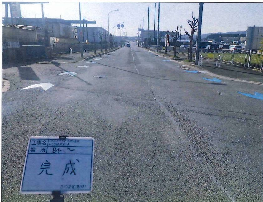
写真区分: 着工前及び完成写真(道路) 写真タイトル: 完成 撮影箇所: No84~
