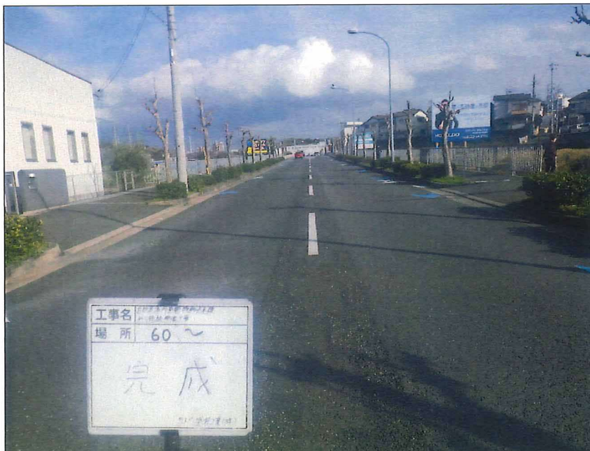
写真区分: 着工前及び完成写真(道路) 写真タイトル: 完成 撮影箇所: No60
