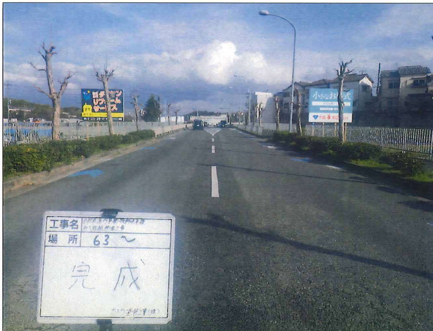
写真区分: 着工前及び完成写真(道路) 写真タイトル: 完成 撮影箇所: No63
