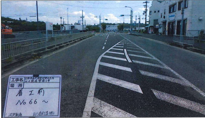
写真区分: 着工前及び完成写真(道路) 写真タイトル: 着工前 撮影箇所: No66~
