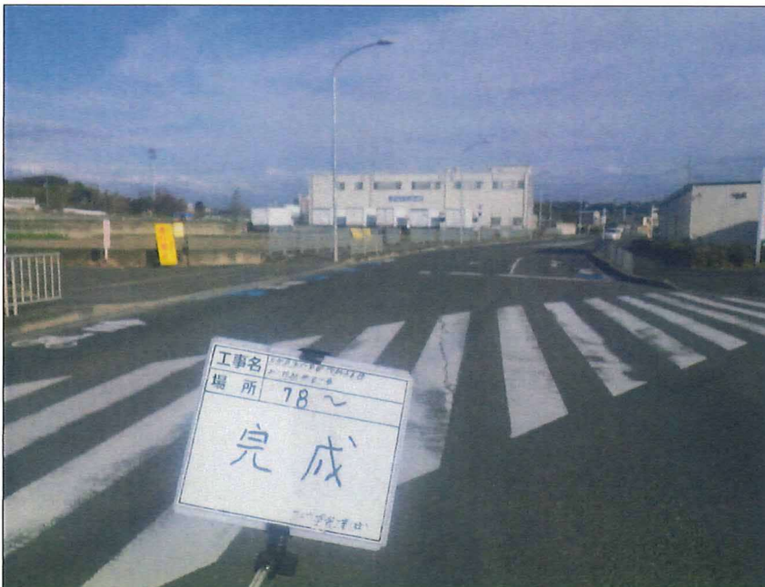
写真区分:着工前及び完成写真(道路) 写真タイトル:完成 撮影箇所:No78
