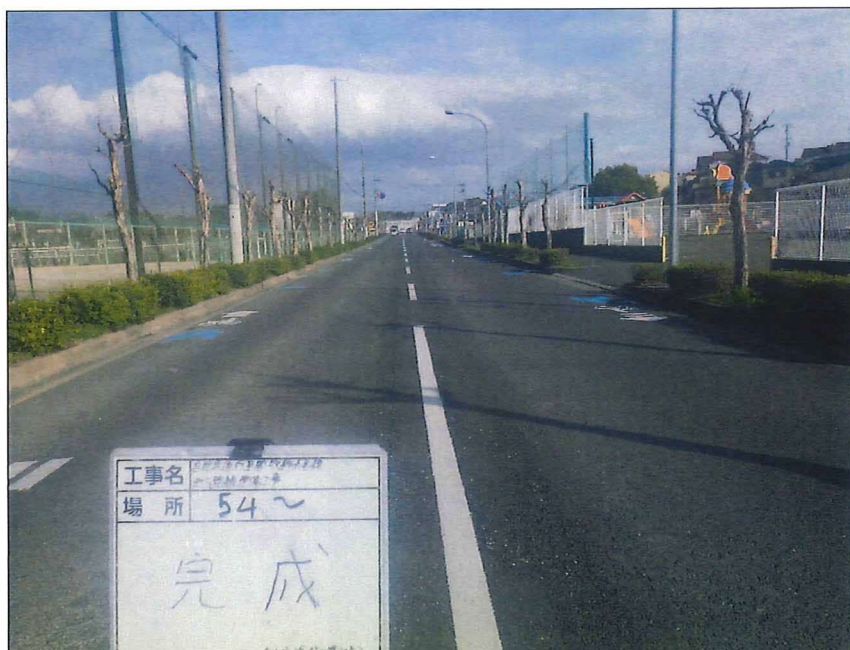
写真区分: 着工前及び完成写 真(道路) 写真タイトル: 完成 撮影箇所: No54~
