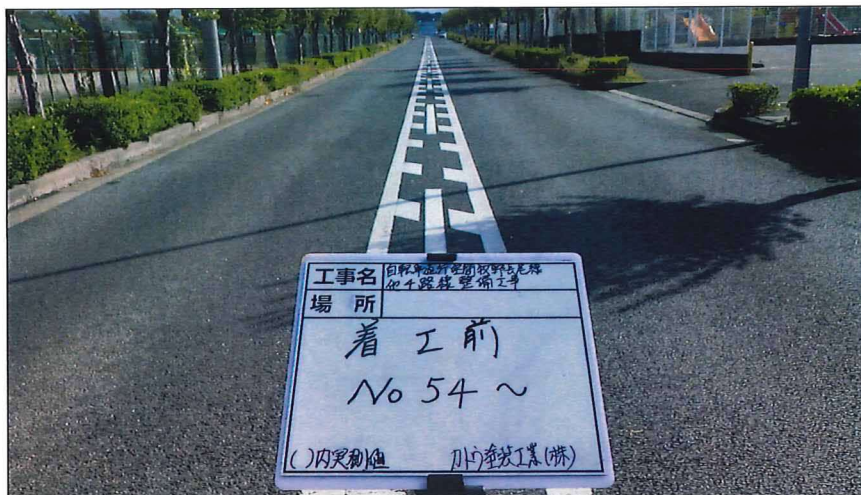
写真区分: 着工前及び完成写 真(道路) 写真タイトル: 着工前 撮影箇所: No54~
