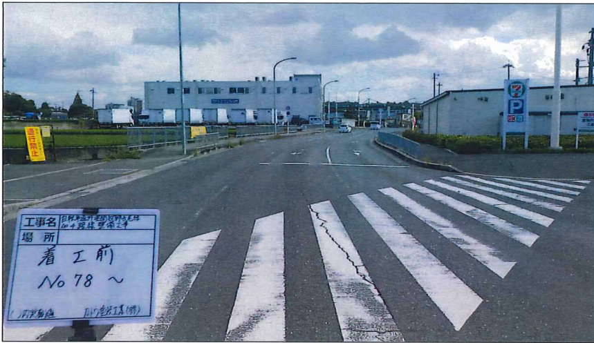
写真区分:着工前及び完成写真(道路) 写真タイトル:着工前 撮影箇所:No78~
