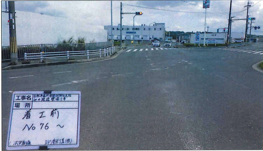
写真区分: 着工前及び完成写真(道路) 写真タイトル: 着工前 撮影箇所: No75~
