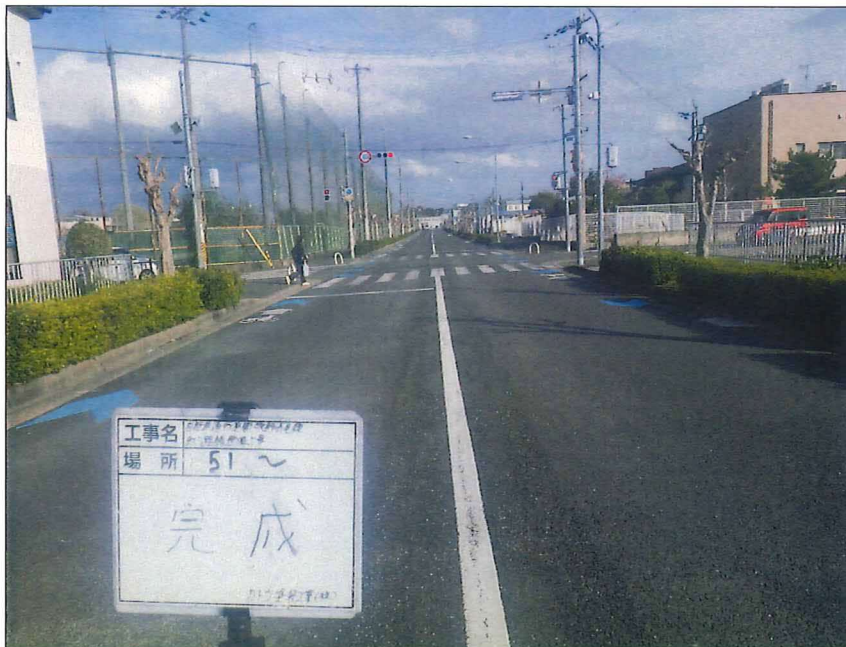
写真区分: 着工前及び完成写真(道路) 写真タイトル: 完成 撮影箇所: No51~
