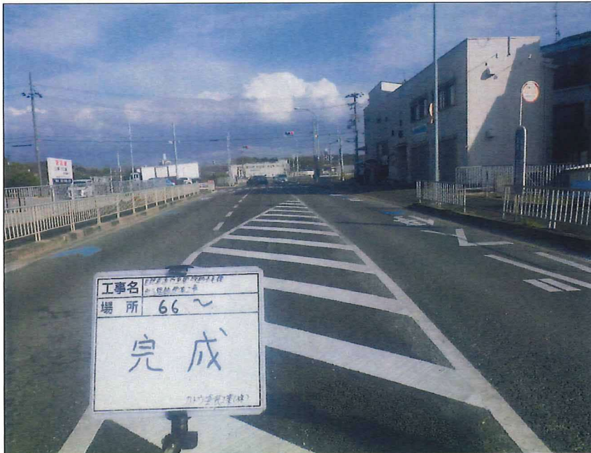
写真区分: 着工前及び完成写真(道路) 写真タイトル: 完成 撮影箇所: No66~
