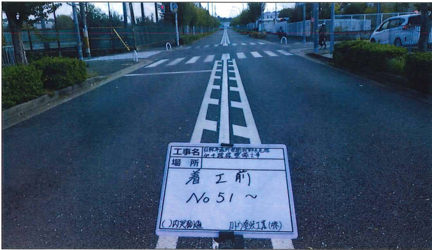
写真区分: 着工前及び完成写真(道路) 写真タイトル: 着工前 撮影箇所: No51~
