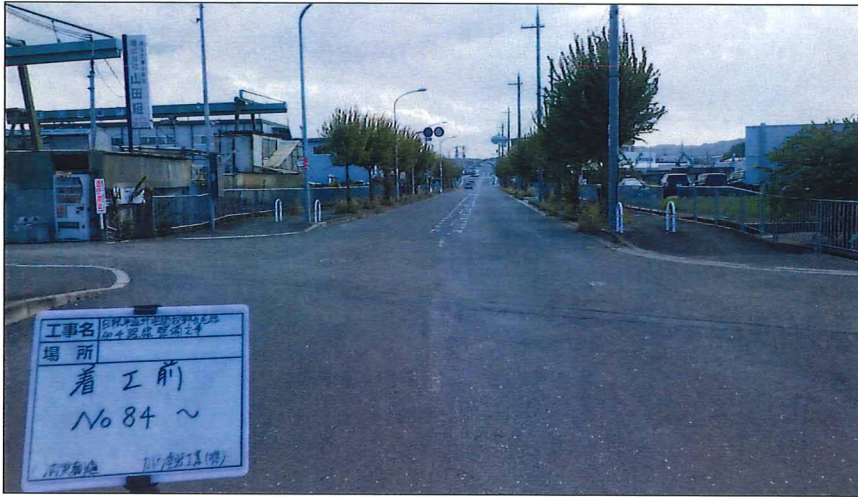
写真区分: 着工前及び完成写真(道路) 写真タイトル: 着工前 撮影箇所: No84~
