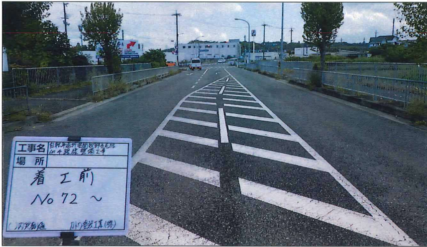
写真区分: 着工前及び完成写真(道路) 写真タイトル: 着工前 撮影箇所: No72~
