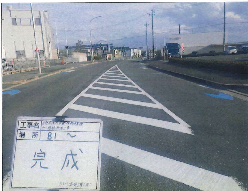
写真区分: 着工前及び完成写真(道路) 写真タイトル: 完成
