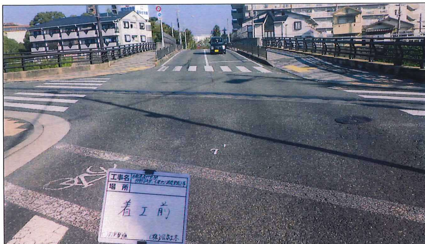
写真区分:着手前及び完成写真 写真タイトル:着工前
