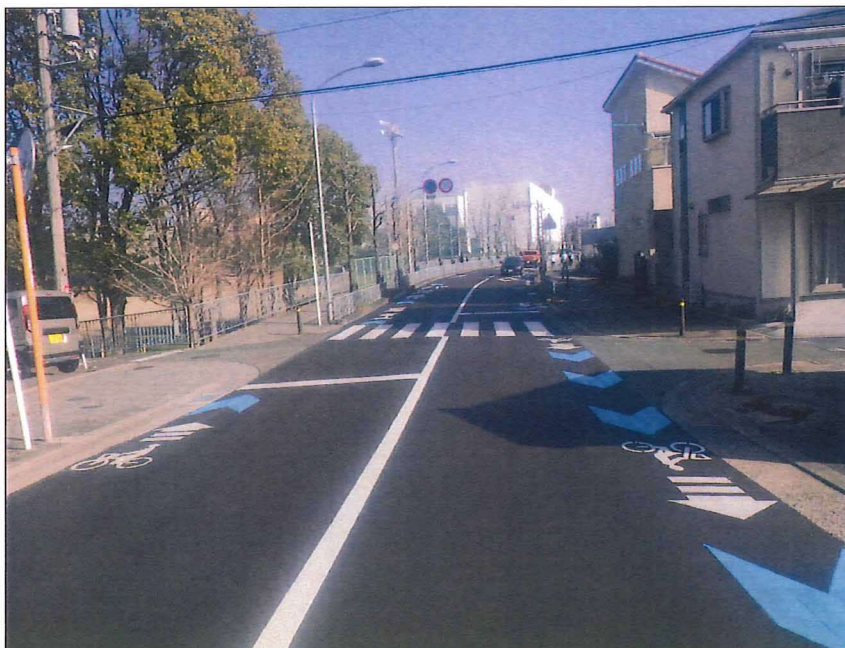
写真区分:着手前及び完成写真
