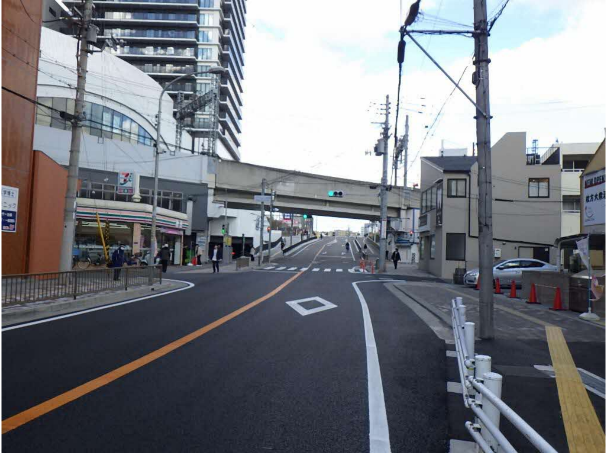
【竣工写真】枚方藤阪線（岡東町地区）道路整備工事（その3）
