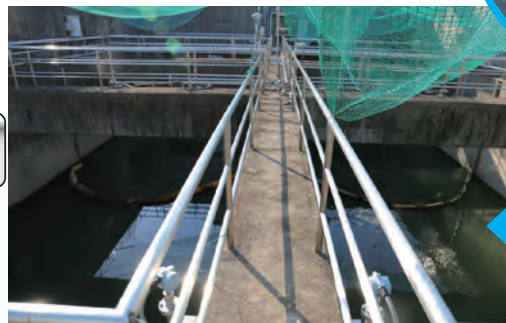
▲小石などを沈める沈砂池
