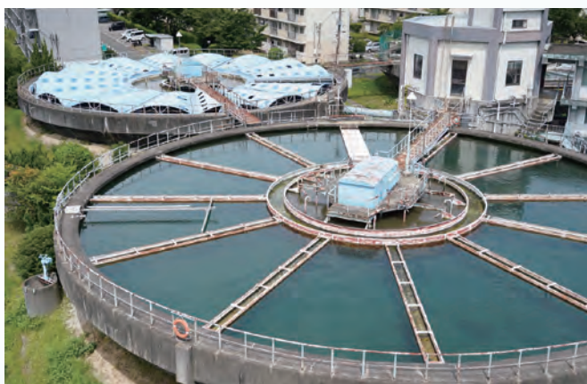
▲水の濁りを塊にして取り除く凝集沈殿池
