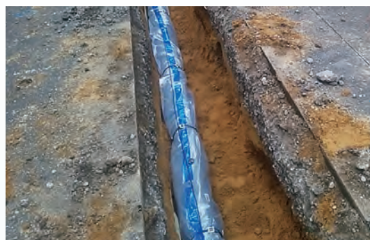
▲取り換え後の水道管
