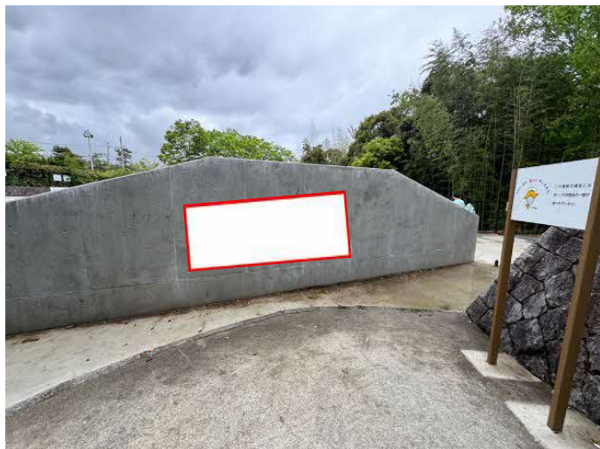
【設置例①】 東側入口
