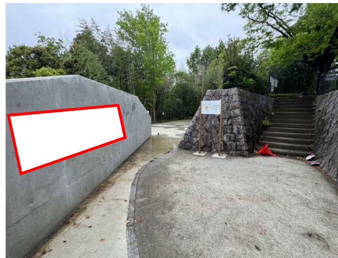
【設置例②】 東側入口（別角度）
