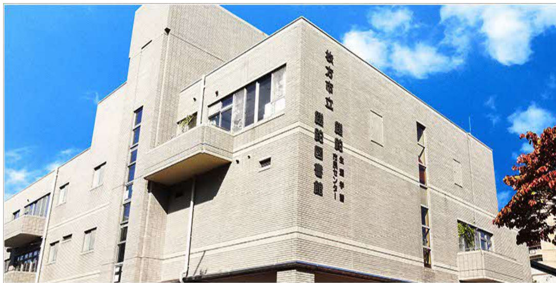
【蹉跎生涯学習市民センターの外観】
