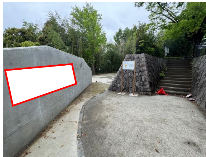
【設置例②】 東側入口（別角度）
