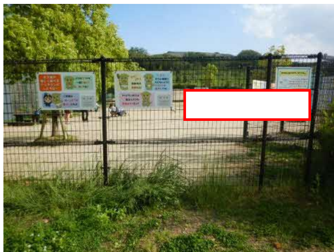
【設置例③】フェンス
