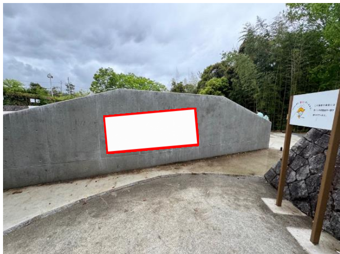
【設置例①】 東側入口
