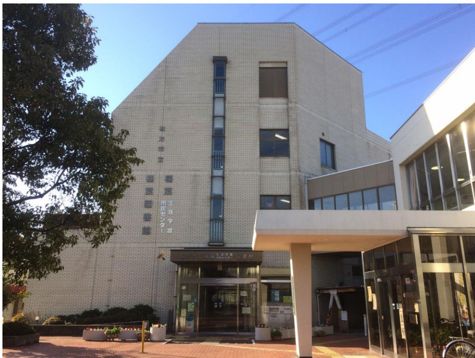
【楠葉生涯学習市民センターの外観】
