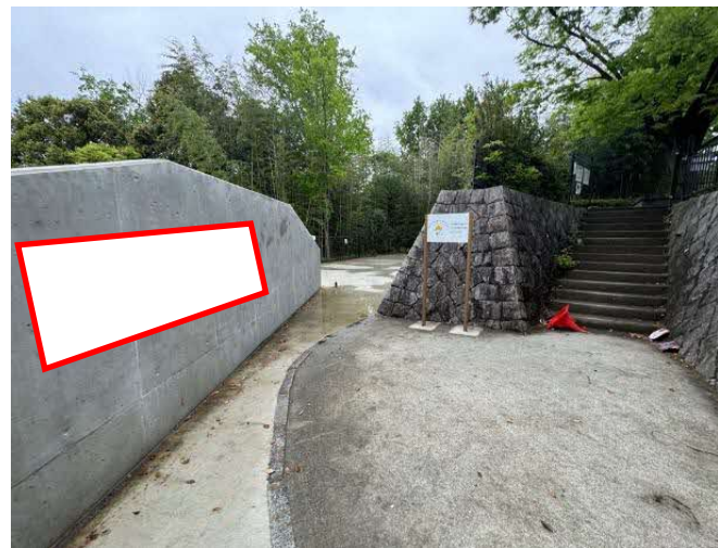
【設置例②】東側入口（別角度）
