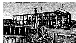
蹠跢ポンプ場
