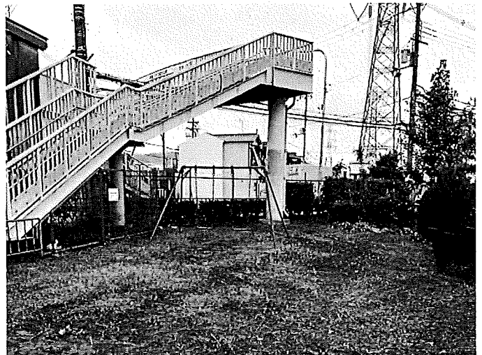
草刈り施工 後
