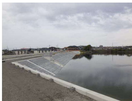
《長尾大池周辺区間の整備工事》
