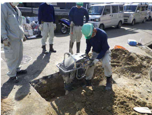
《道路陥没の復旧作業》
