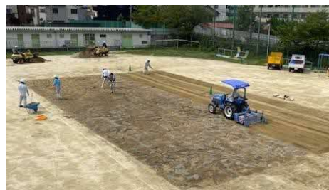
グラウンド改修の作業状況
