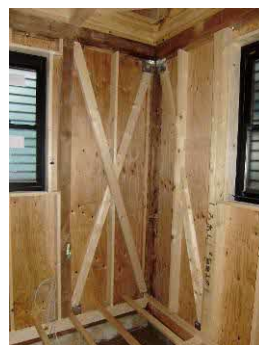
改修事例：筋交い補強
