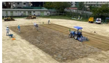
グラウンド改修の作業状況
