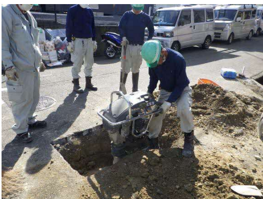
《道路陥没の復旧作業》
