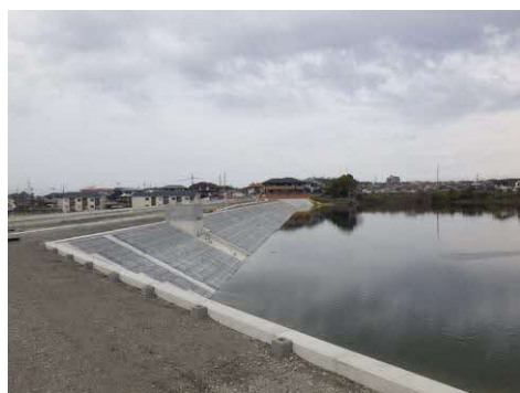
《長尾大池周辺区間の整備工事》
