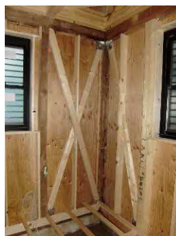
改修事例：筋交い補強
