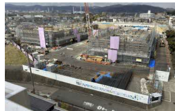
工事状況（令和7年2月時点）
