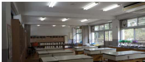
照明器具のLED化
