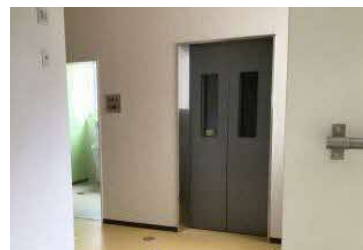
学校エレベーター
