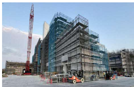
可燃ごみ広域処理施設
