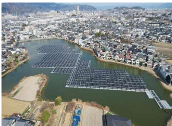
フロート式太陽光発電設備 上：招提新大池 下：招提今池
