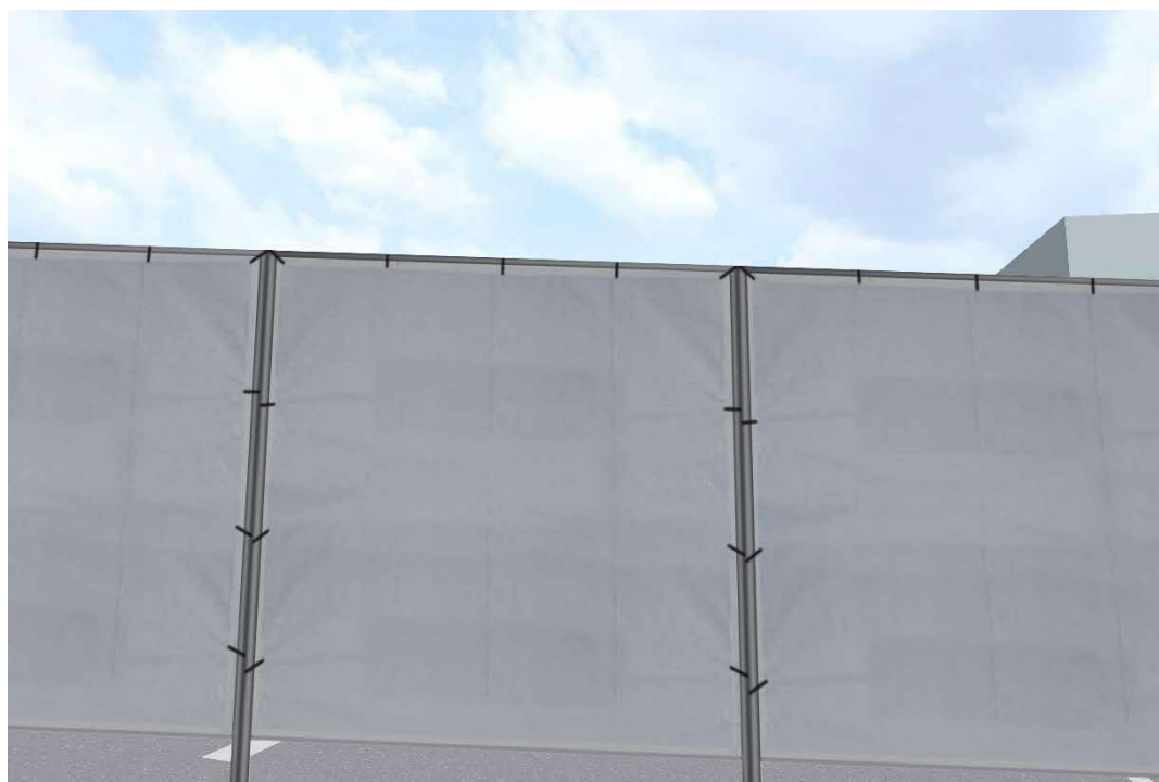
図 3.5-5 近景 No.3 : 第二京阪道路高架下付近
