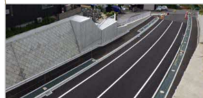
中振交野線（透水性舗装）
