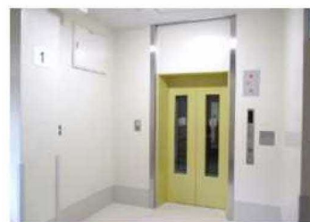
エレベーター
