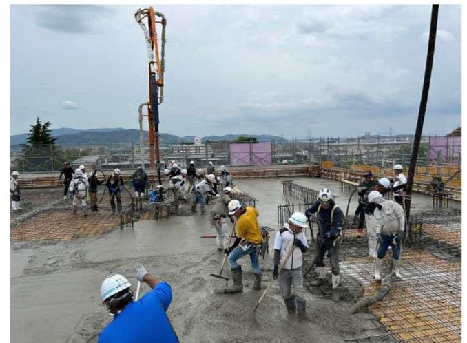
3 工区 躯体コンクリート打設中
