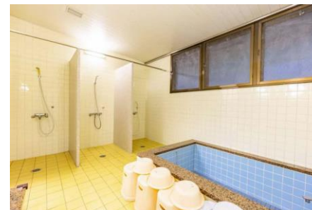
小浴場(シャワー7基)
