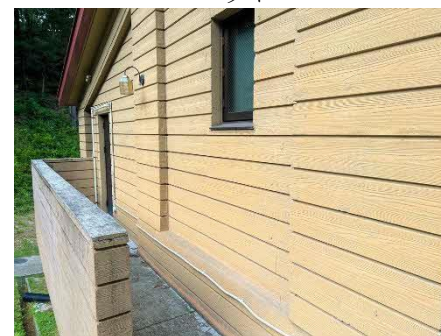
車いすスロープ ※ 5棟中 1棟のみ
