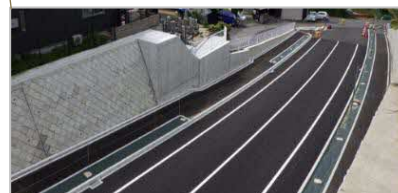
中振交野線(透水性舗装)
