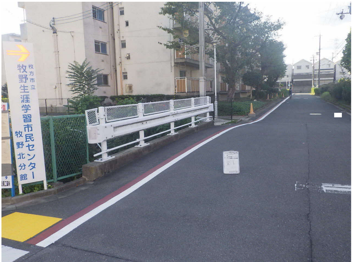
【完了後】牧野北町バリアフリー整備工事
