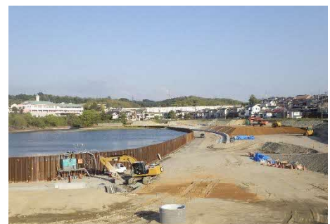
《長尾大池周辺区間の整備工事》
