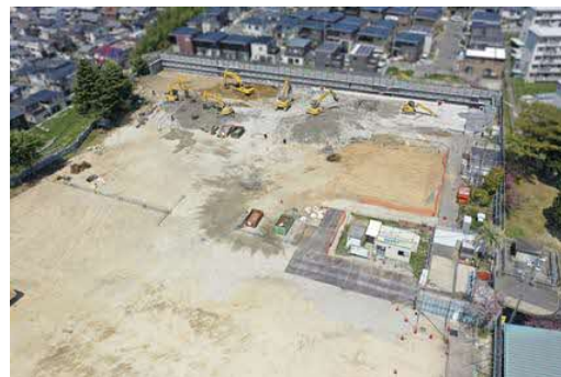
(解体状況 令和5年4月時点)
