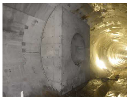
<地下での流入管の接続>
