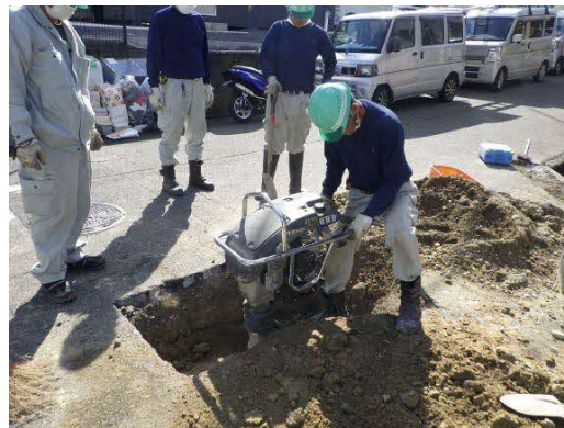
《道路陥没の復旧作業》
