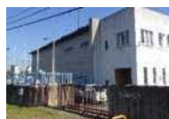
溝谷川ポンプ場
