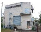
安居川ポンプ場
