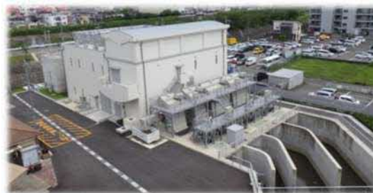
完成した新安居川ポンプ場
