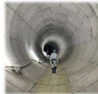
完成した貯留管の内部
