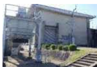
北部ポンプ場
