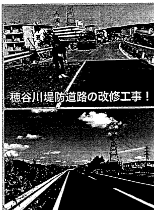
穂谷川堤防道路工事
