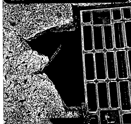
枚方パーク前歩道の側溝溝補修
