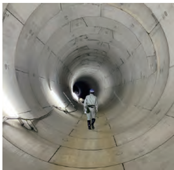
▲貯留管の内部（直径約5m）
