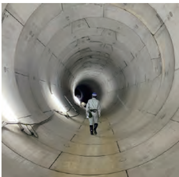
▲貯留管の内部（直径約5m）
