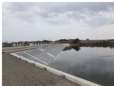
《長尾大池周辺区間の整備工事》
