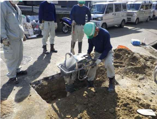
《道路陥没の復旧作業》
