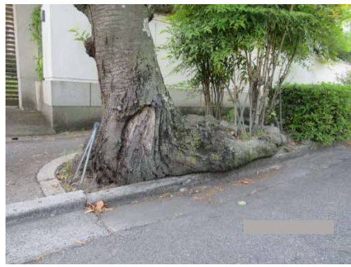
写真6 大木化により植栽枠より幹や根がはみ出した事例
