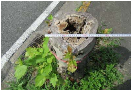
写真14 空洞ができた街路樹の事例
