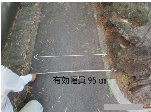
写真7 狭小な歩道幅員に植栽している事例
