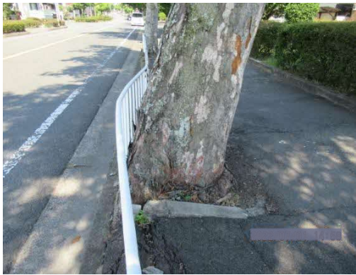
写真6 大木化により植栽枠より幹や根がはみ出した事例
